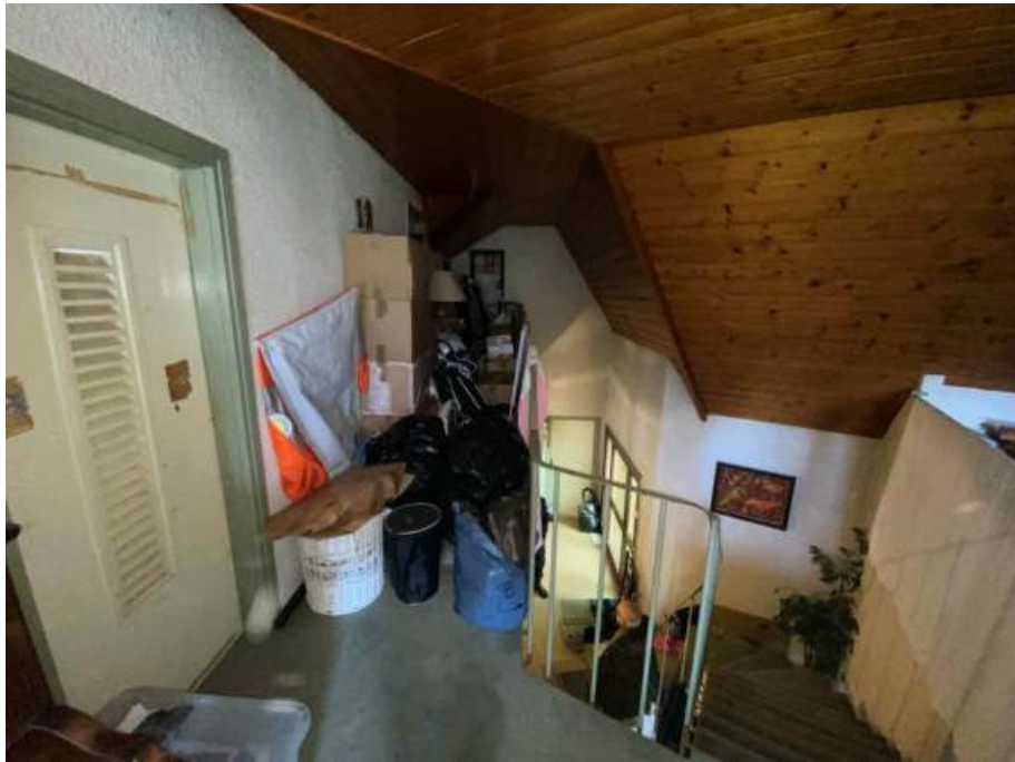
Couloir de distribution sur la gauche en montant :
