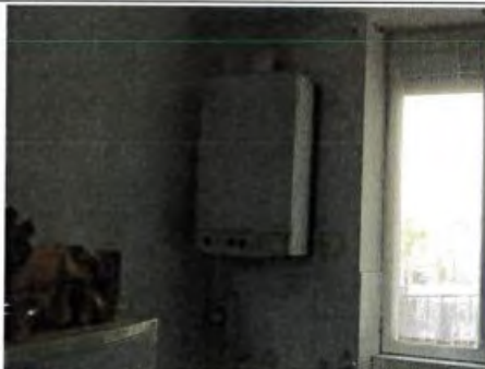
Photo n° PhGaz001 Localisation : Pièce à vivre Chaudière (Type : Etanche) Localisation sur croquis : Pt001
