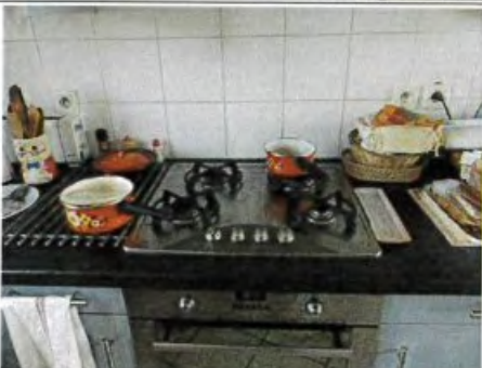
Photo n° PhGaz002 Localisation : Pièce à vivre Table de cuisson (Type : Non raccordé) Localisation sur croquis : Pt002
