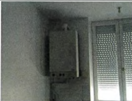
Photo n° PhGaz001 Localisation : Pièce à vivre Chaudière Initia 2,24 FF (Type : Etanche) Localisation sur croquis : Pt001
