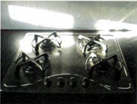
Photo n° PhGaz002 Localisation : Pièce à vivre Cuisinière (Type : Non raccordé) Localisation sur croquis : Pt002
