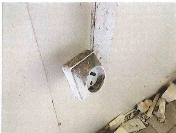
**Local contenant une baignoire ou une douche : l'installation électrique ne répond pas aux prescriptions particulières appliquées à ce local (adéquation entre l'emplacement où est installé le MATERIEL ELECTRIQUE et les caractéristiques de ce dernier - respect des règles de protection contre les chocs électriques liées aux zones).**
