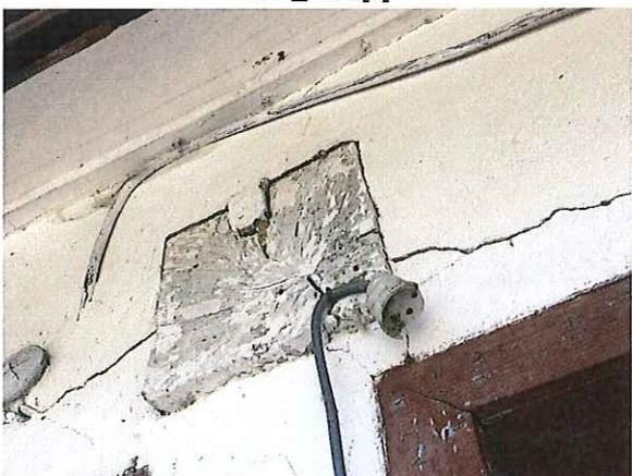
**L'installation électrique comporte au moins un dispositif de protection avec une partie active nue sous tension accessible.**
